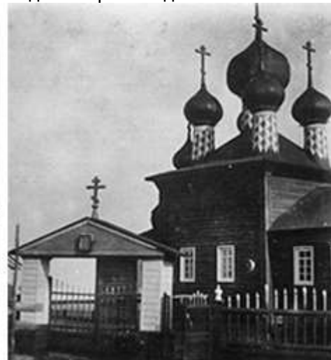
Вид с северо-запада
