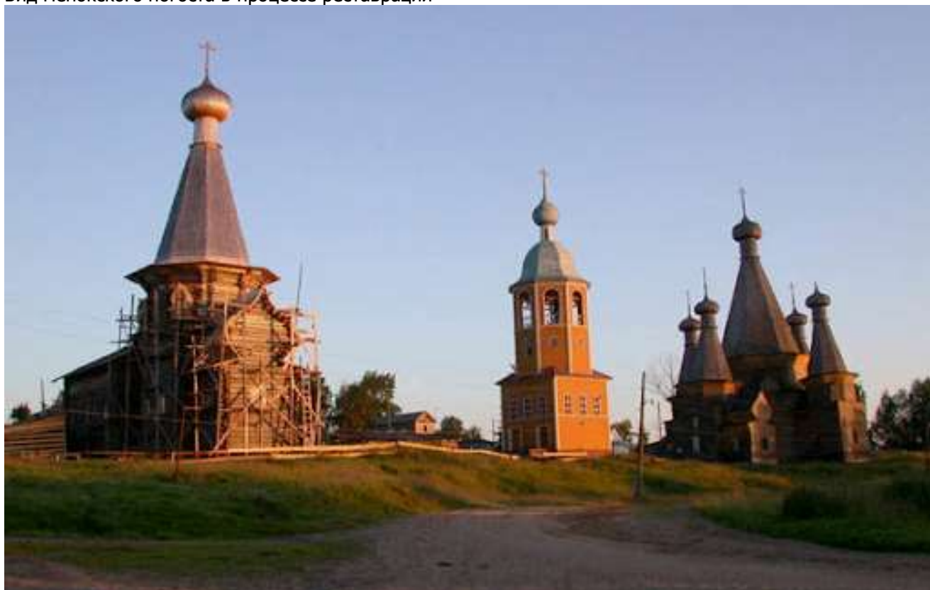
Вид Ненокского погоста в процессе реставрации
