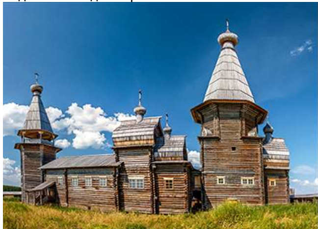
Вид ансамбля до покраски
